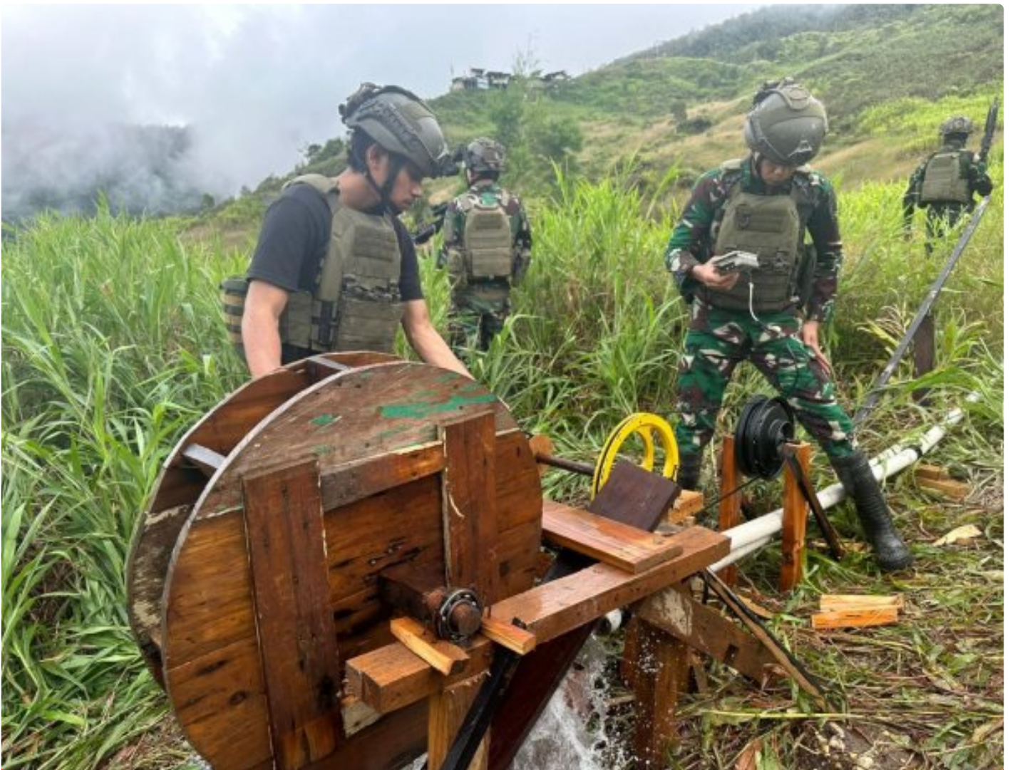
Foto: Saat Prajurit Yonif Linud 432 /WSJ Membuat Pembangkit Listrik Tenaga Air (PLTA) di Distrik Mapenduma, Kabupaten Nduga, Papua Pegunungan, Senin (1/07/2024).
